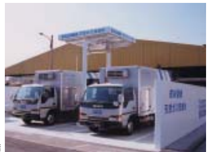
CNGガススタンド淀川店
